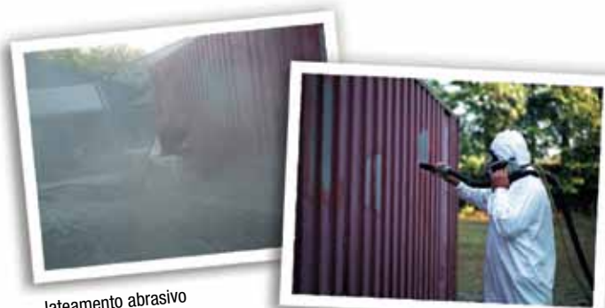
Jateamento abrasivo com baixa produção de pó com Sponge-Jet
