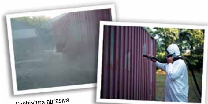
Sabbiatura abrasiva a bassa emissione di polvere con Sponge-Jet
