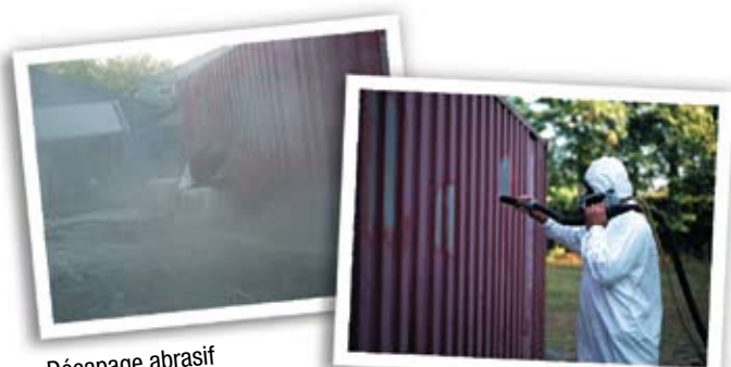
Décapage abrasif avec un minimum de poussière, avec Sponge-Jet
